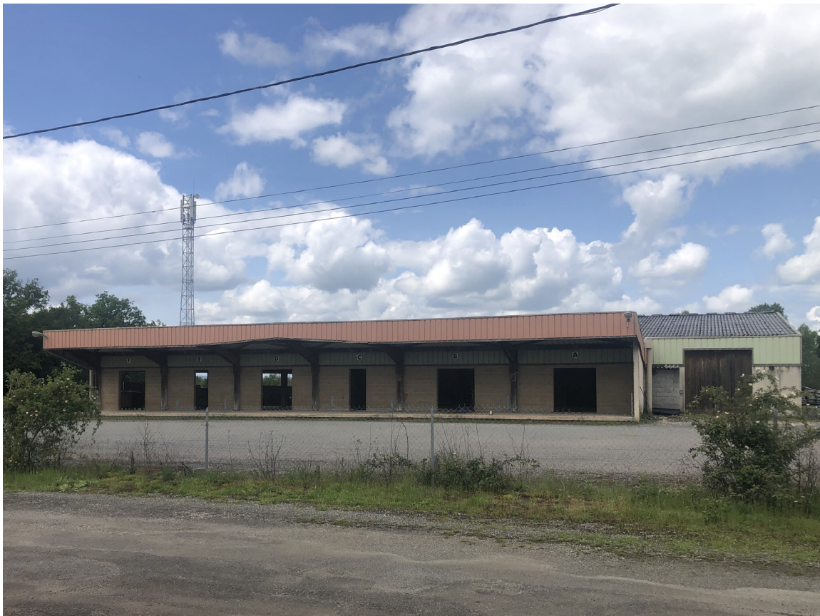
6299 Photographie de l'ancien marché couvert. Source : Photographie ADR
