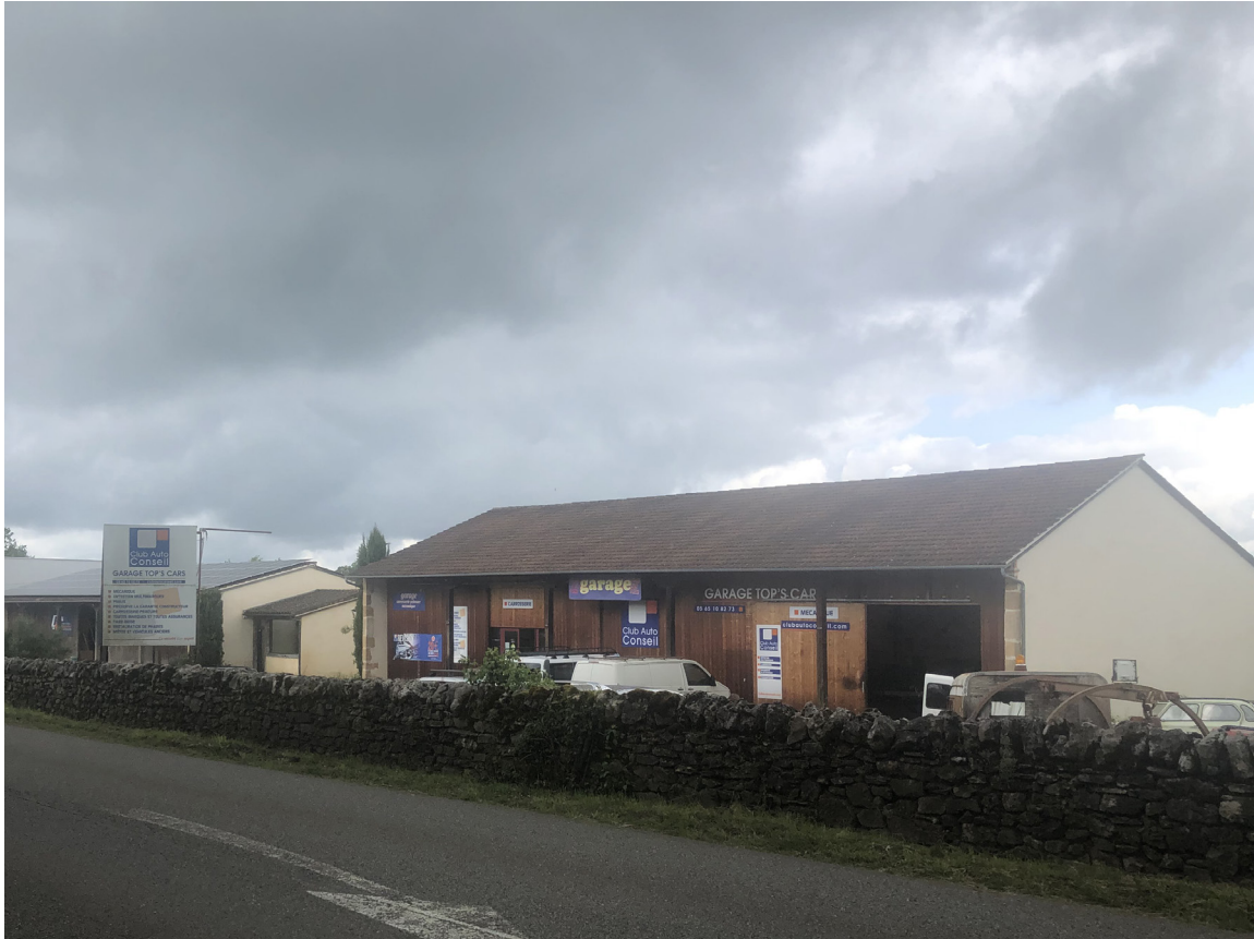
6169 Locaux de l'entreprise CRT. Source : Photographies ADR
