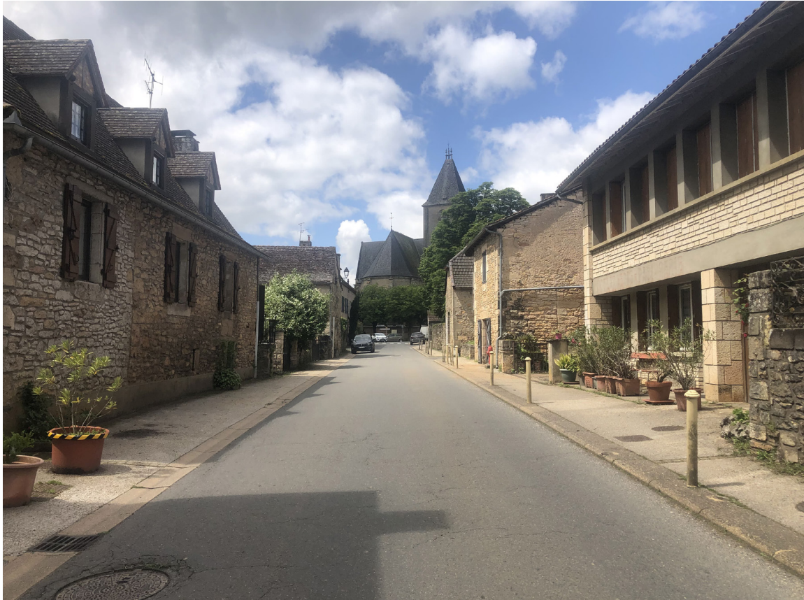
Vue de la traverse du bourg d'Assier. Source : Photographies ADR
